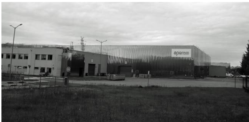
Fot. 29. Zakłady Aperam Stainless Services and Solutions Poland przy ul. Krupanka
