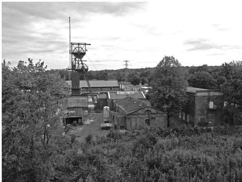
Fot. 16. Zabudowania szybu „Bańgów” – widok współczesny
